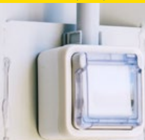
Électricité pour pièce humide
