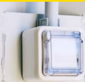
Électricité pour pièce humide
